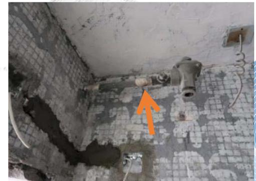
不得將用戶喉氣安裝在不通風的豎氣管道、橫氣管道或空洞
